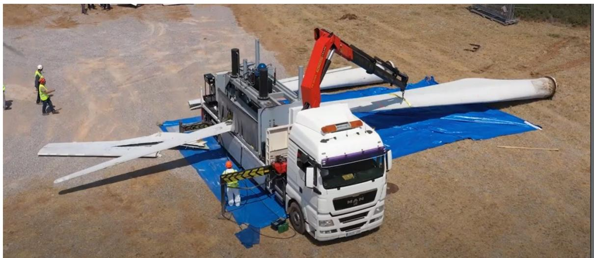
Figure 13 : Découpe et compression des pâles de la première éolienne de France
