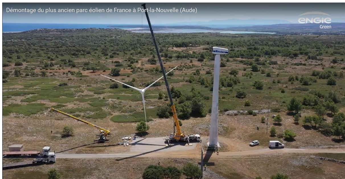
Figure 12 : Démontage des pales de la première éolienne de France
